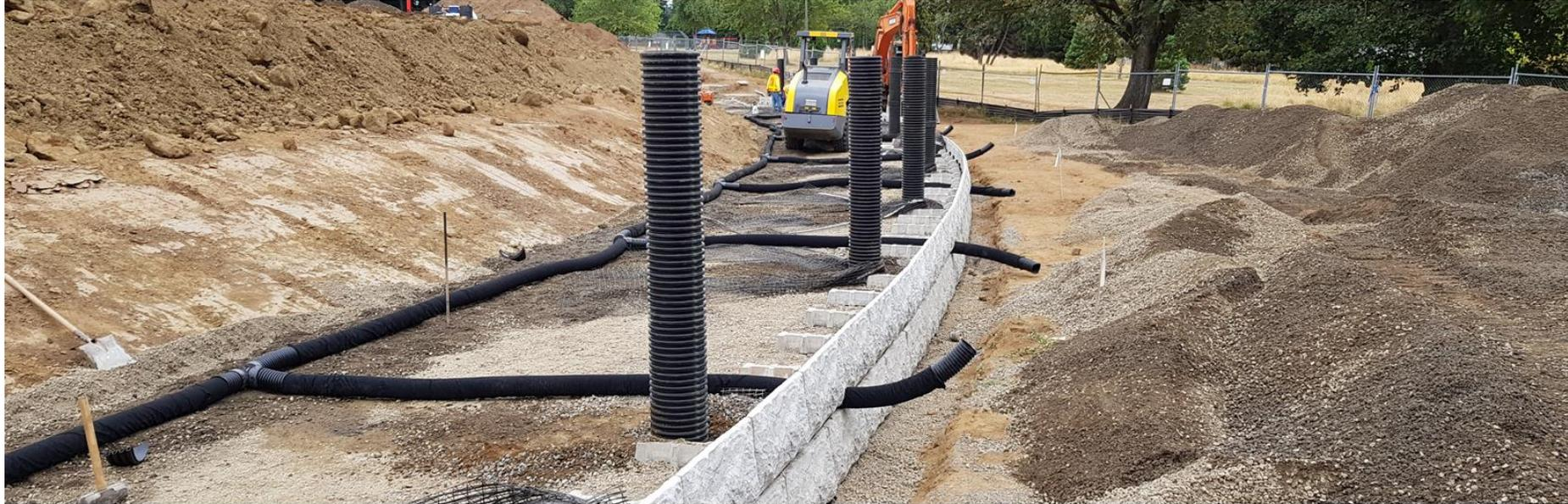
Además de las cualidades drenantes del material de relleno, se instala un sistema de drenaje para prevenir empujes adicionales por presión de agua acumulada en el tras dos del muro.
