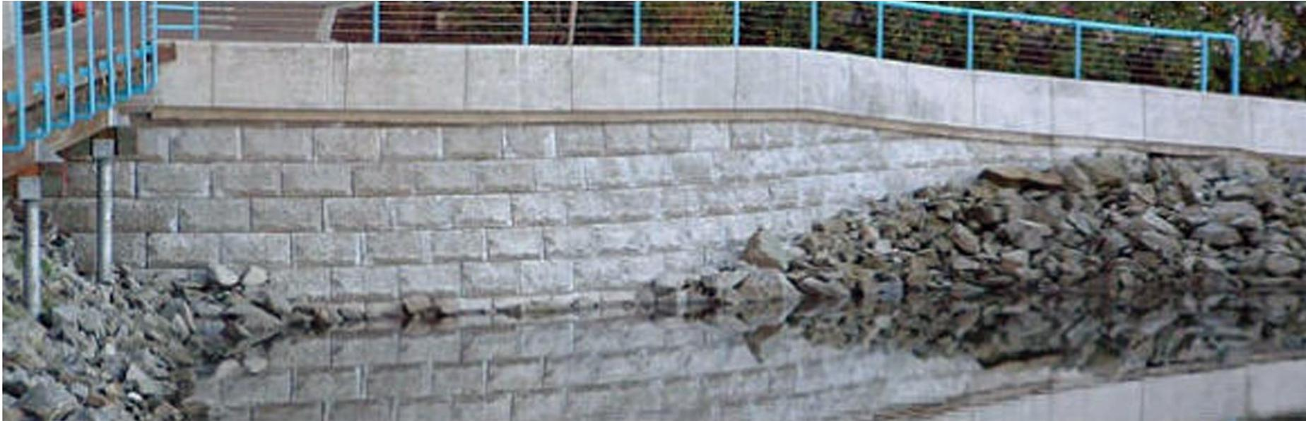
La instalación de material granular de mayor tamaño en el frente del muro, permite instalar muros **LOCK+LOAD** en situaciones de contacto directo y constante con el agua.
