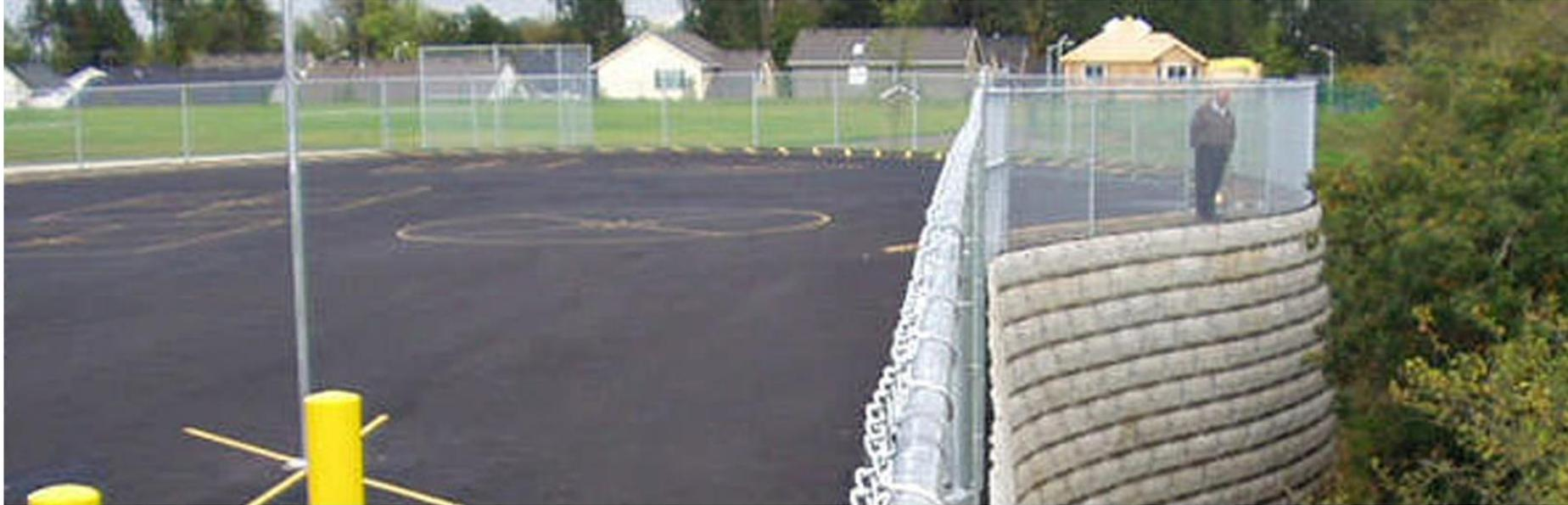
La capacidad de compactar hasta el borde del panel, permite la instalación de cierres perimetrales o barreras de tránsito directamente sobre la corona del muro.
