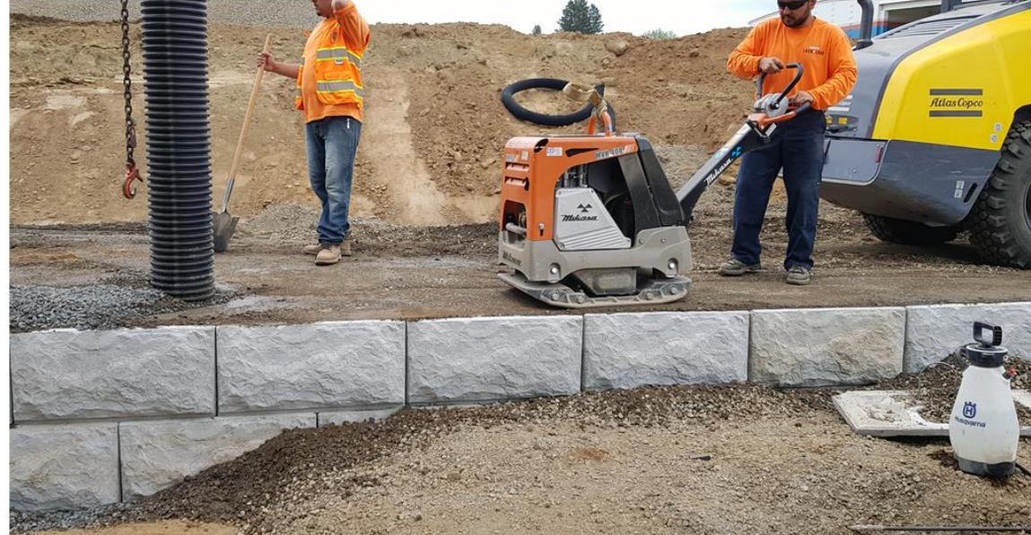
La alta resistencia de los paneles permite la compactación deseada hasta el borde del muro, además de la utilización de equipos pesados para lograrla.
